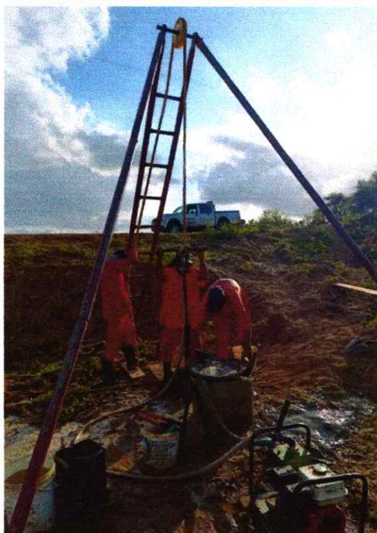
Figura 2. Execução de sondagem SP-01
