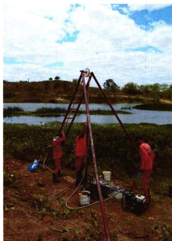
Figura 5. Execução de sondagem SP-02
