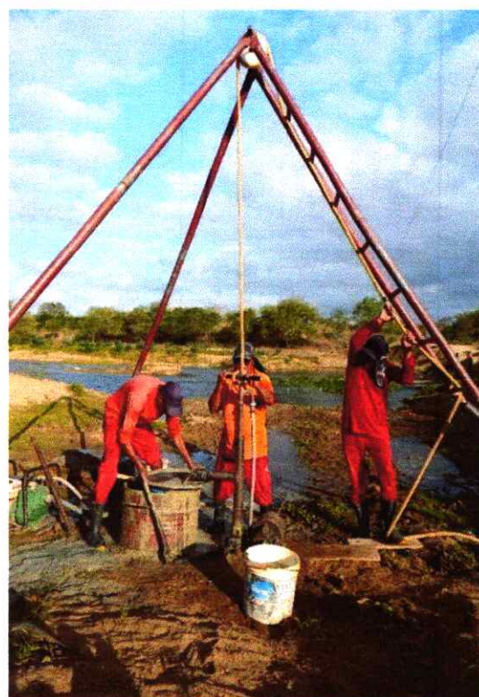
Figura 3. Execução de sondagem SP-01
