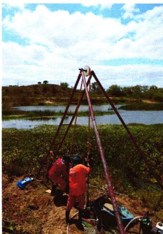
Figura 4. Execução de sondagem SP-02
