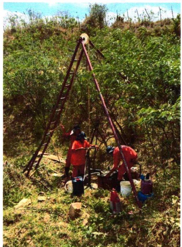
Figura 7. Execução de sondagem SP-03
