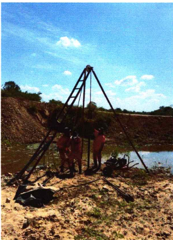
Figura 8. Execução de sondagem SP-04
