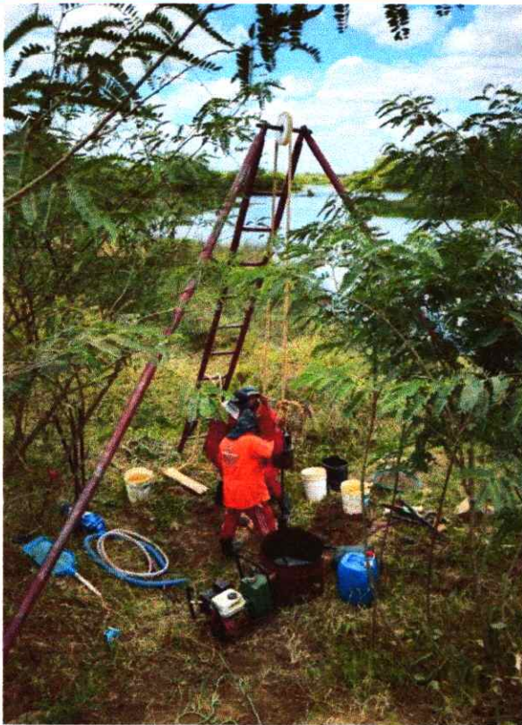
Figura 6. Execução de sondagem SP-03
